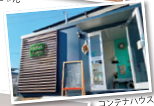
コンテナハウス
