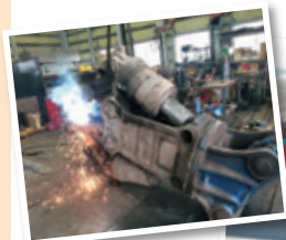
大割庄砕機の溶接修理
