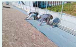
ルーフィング施工
