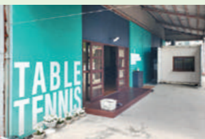
倉庫を改修したスタジオ
